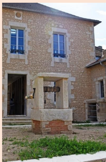
Rénovation du presbytère à Bonnes
