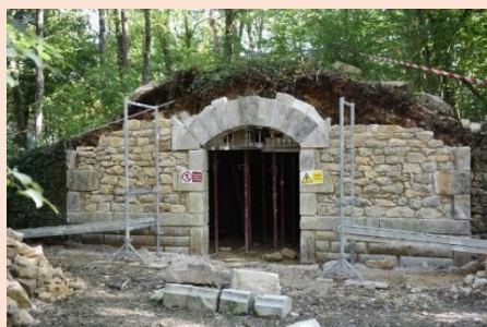
Rénovation d'une cave voûtée à Vernon
